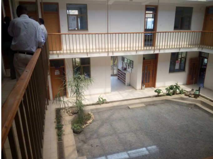
Eingang ins Gebäude
