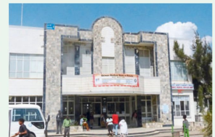
Das Ayder Referral Hospital sollte Vorbild für weitere Krankenhäuser in Äthiopien sein.
